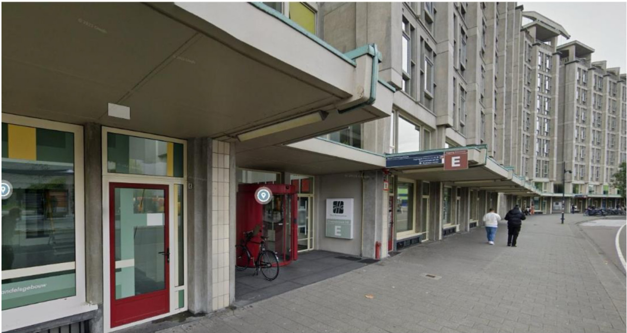
Foto 1: Ingang vleugel E
